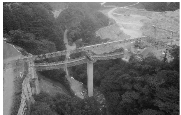
写真-1.1 架設前の状況
