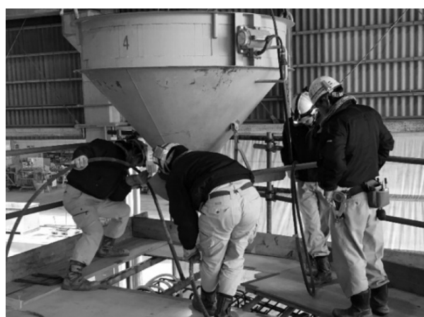
写真-3.2 コンクリート打込み状況
