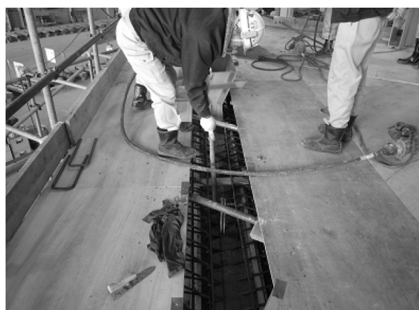
写真-3.3 コンクリート振動締固め状況
