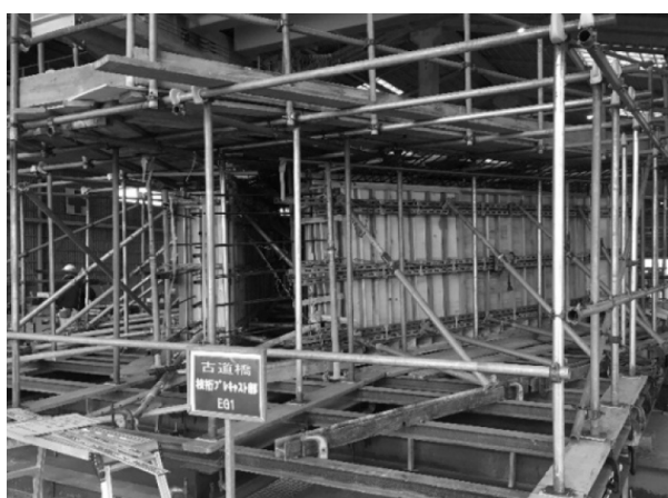
写真-3.1 型枠組立状況
