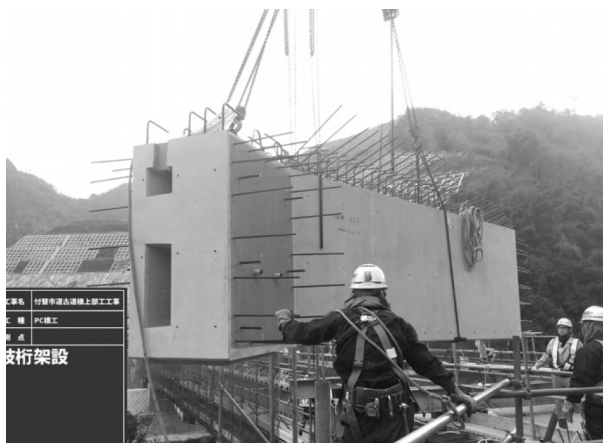
写真-3.7 枝桁のクレーン架設状況
