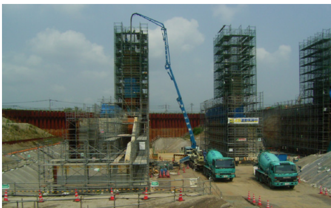
写真-1.1 施工状況
